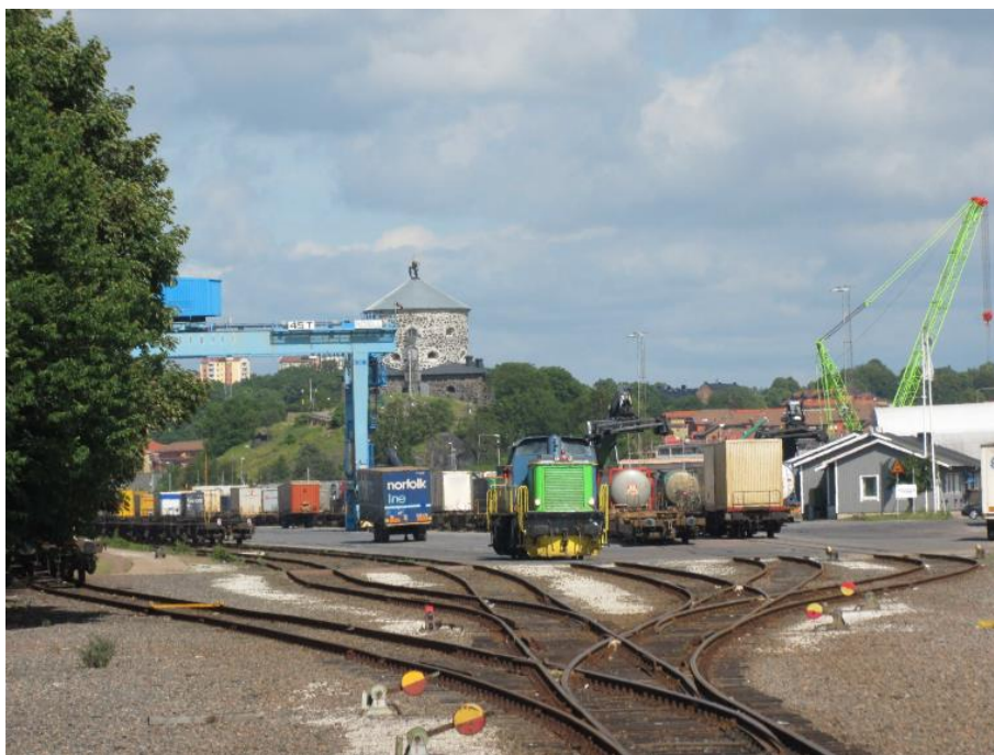
Figur 6. Bild tagen från terminalens västra del där de sex spåren går samman till det stickspår som kommer att behöva avlägsnas enligt aktuellt planförslag. (3).
